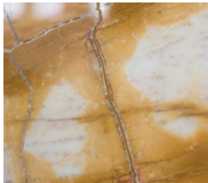
resinatura fessura (dettaglio) slot resin coating (detail)
