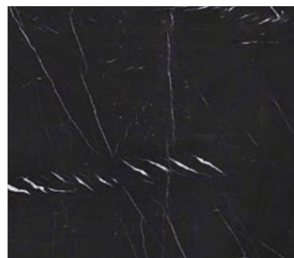
linee di screpolatura (dettaglio) cracking lines (detail)
